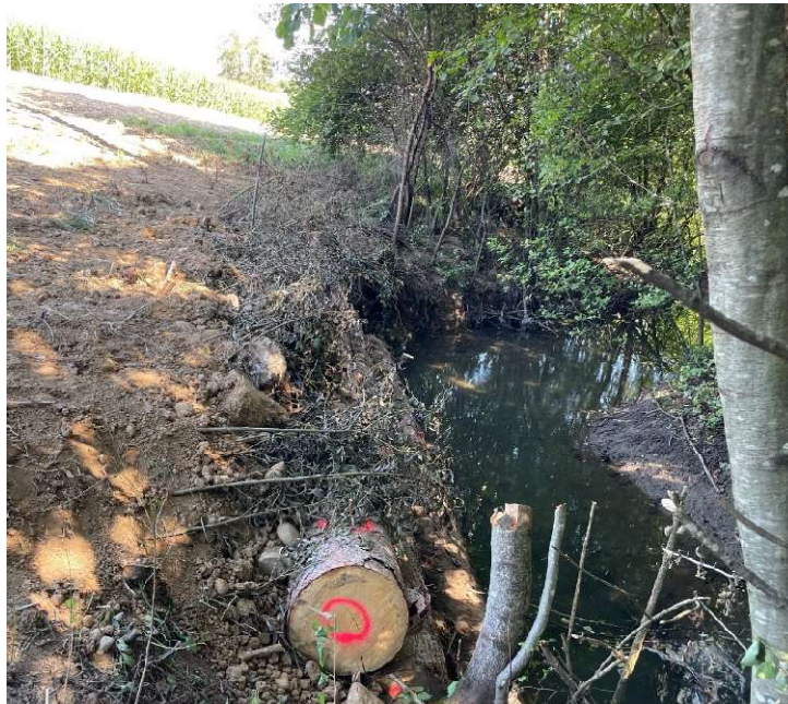
Die Uferbefestigung im Rickenbach Richtung Freienwil wurde 2024 durch den Forstbetrieb erstellt.
