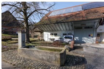
Platz mit Linde und Brunnen in der Nähe der zentralen Weggabelung im oberen Teil des Weilers.
