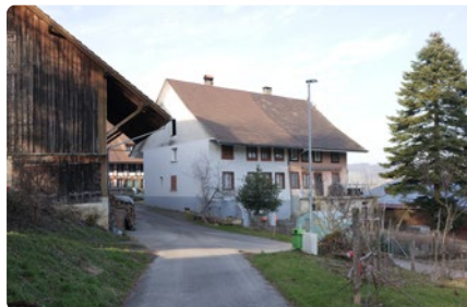
Strassengabelung mit abgewinkelter Gebäudestellung, Wiesen und Gärten.
