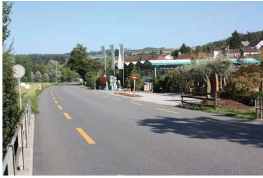
bestehende Zufahrt Garten-Center mit provisorischer Anlieferungslösung
